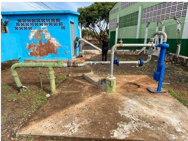
Figura 49 – Poço UP 09 com sistema de filtragem.
