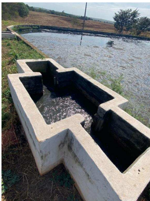
Figura 125 – Chegada do Efluente na Lagoa Anaeróbia.
