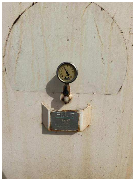
Figura 108 – Medidor de pressão – Res 11.
