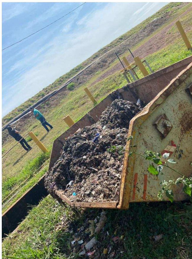
Figura 122 – Caçamba de ac4mulo de res4duos s4lidos oriundos da EEE ETE Guar4.
