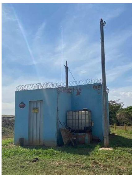
Figura 132 – Casa do Gerador.
