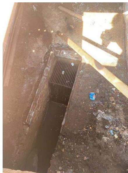
Figura 119 – Gradeamento da EEE Quinze de Setembro.
