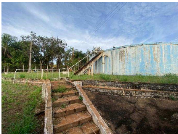
Figura 101 – Acesso ao Res 03.
