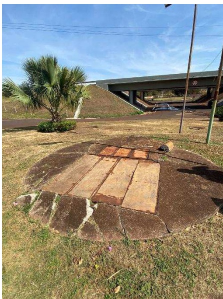
Figura 118 – Estação Elevatória de Esgoto Quinze de Setembro.
